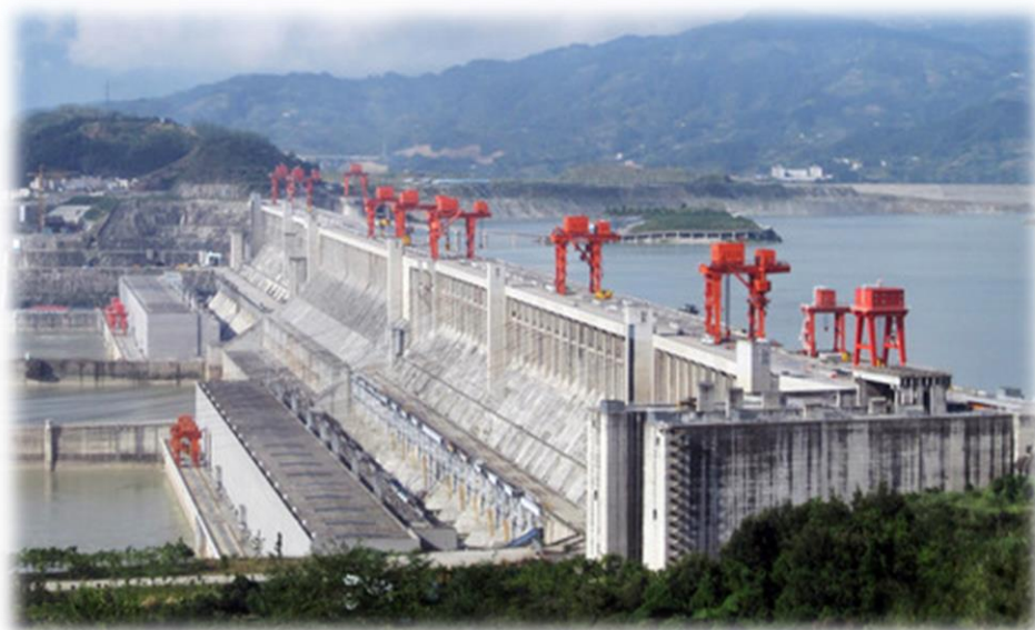
Zapora Trzech Przełomów na rzece Jangcy jest częścią największej na świecie elektrowni wodnej o mocy 22 500 MW
